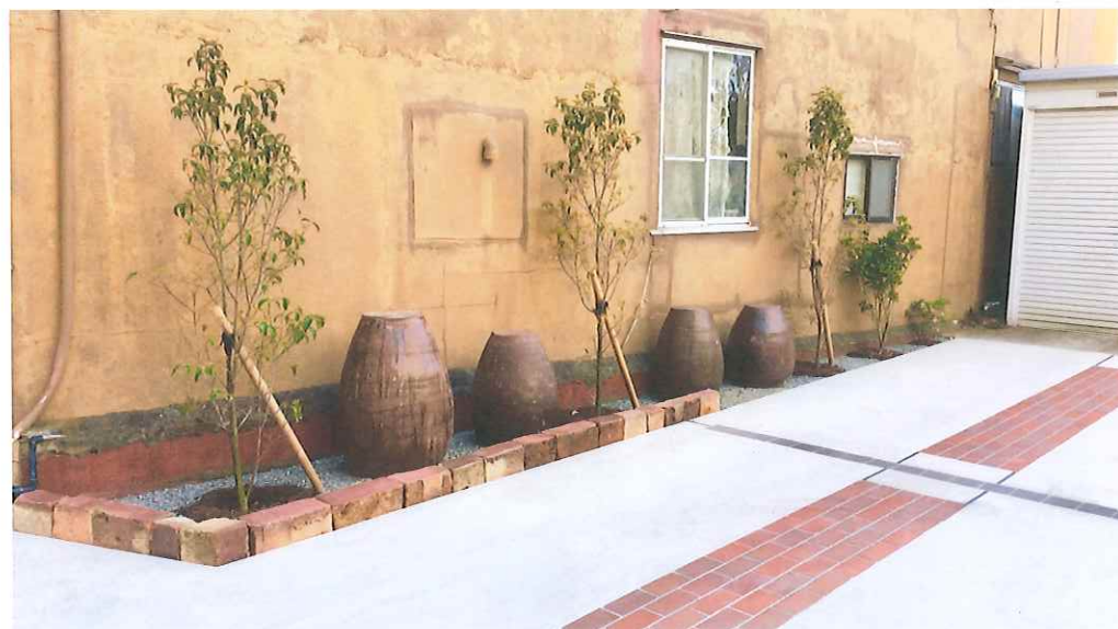
施工後：左側（植栽、甕・登り窯レンガ）
